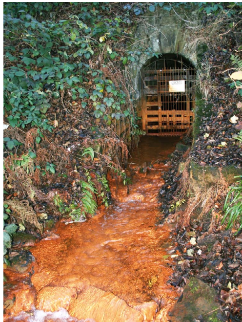
Abb. 103: Mundloch des St.-Johannes-Erbstollens; Ruhrtal bei Witten. – Die rostbraune Verfärbung des Gerinnes ist auf ausgeflocktes Eisenoxid zurückzuführen.
