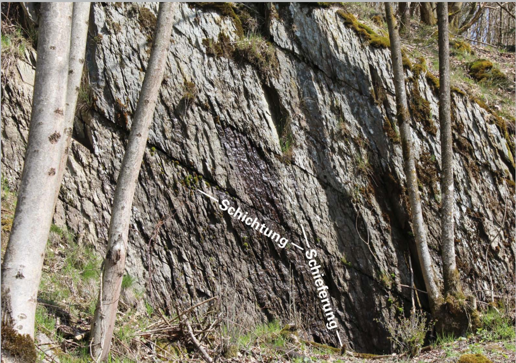
Abb. 9: Intensiv geschieferte Tonsteine der Oberen Nehden-Schichten. Die Schieferung ist steiler geneigt und enger als die Schichtung. Aufschluss an der B 236 kurz vor dem Abzweig nach Hallenberg-Liesen
