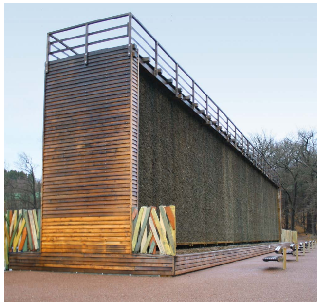
Abb. 106: Gradierwerk am Freizeitbad NASS; Arnsberg-Hüsten
